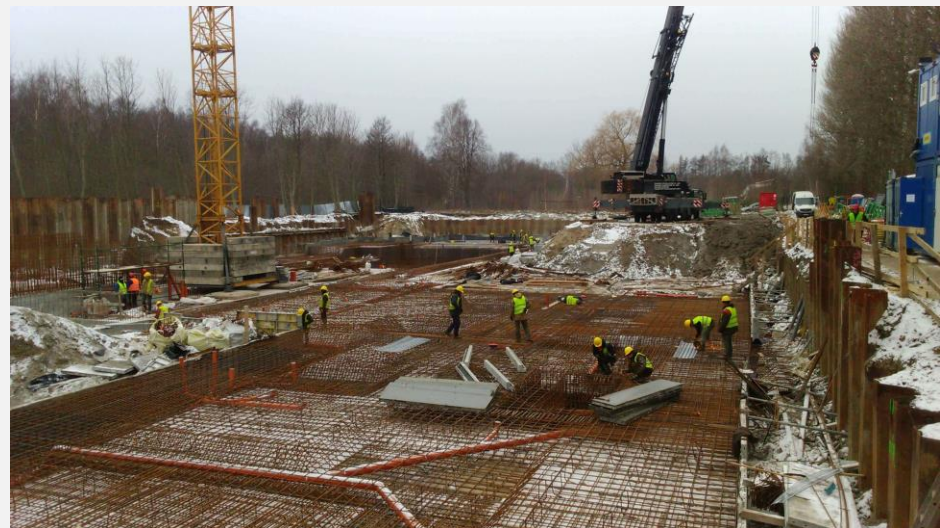
Zdjęcia z budowy hotelu H2O we wschodniej dzielnicy uzdrowskiej. Widoczne są prace fundamentowe z zastosowaniem ścianki szczelnej oraz osuszaniem gruntu do głębokości 1 m p.p.m. (głębokość do 5 m p.p.t.)
