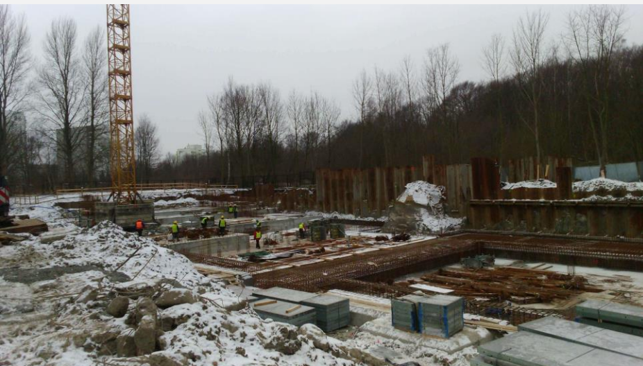
Zdjęcia z budowy hotelu H2O we wschodniej dzielnicy uzdrowskiej. Widoczne są prace fundamentowe z zastosowaniem ścianki szczelnej oraz osuszaniem gruntu do głębokości 1 m p.p.m. (głębokość do 5 m p.p.t.)
